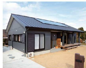
ソーラーパネルを搭載した切妻屋根は、集熱効率の高いガルバ葺き。落ち着いたダーク調の外観は、スタイリッシュな印象を与える。
